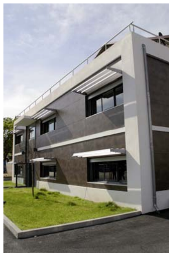
Bâtiment secteur Déchets Ateliers Nord Croix Sainte
