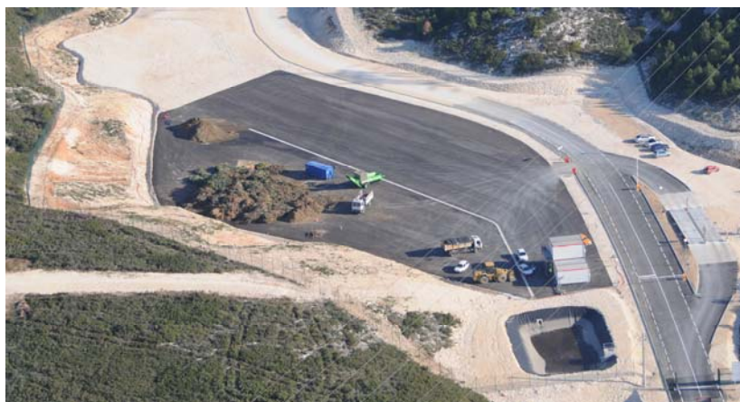
Vue aérienne de la plate forme de compostage en début d'exploitation
